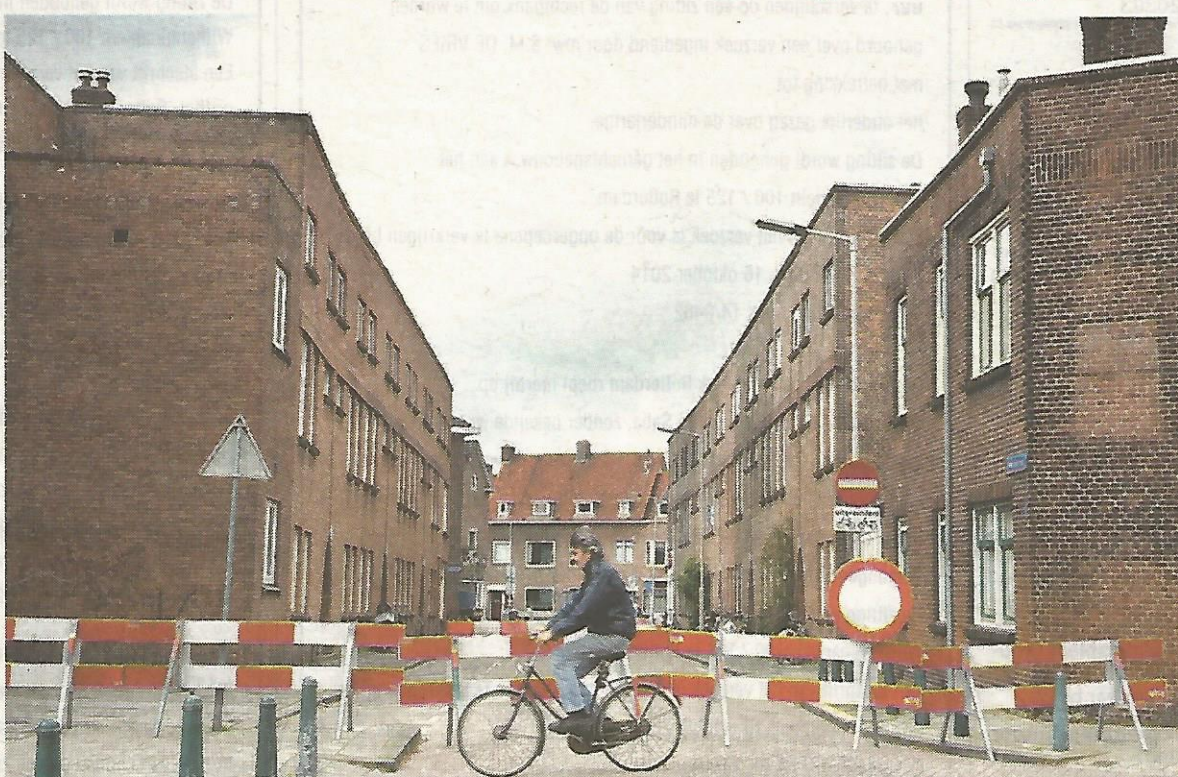
▲ De Margrietstraat vlak na de ontruiming. Bewoners mochten hun huis niet in. ARCHIEFFOTO SANNE DONDERS
